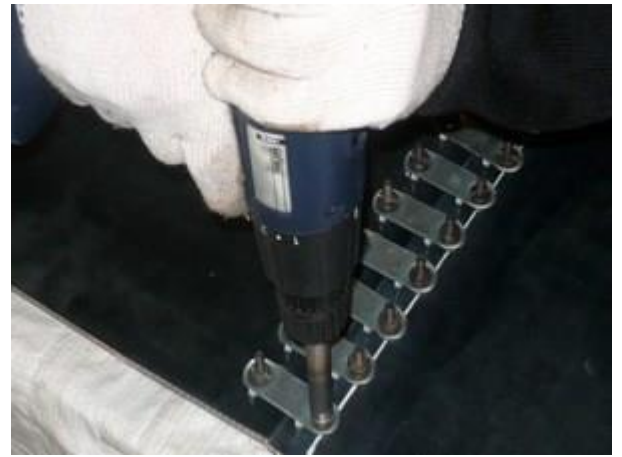
Протягиваем гайки шуруповёртом (а)
