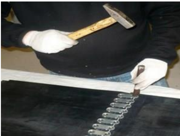
Чтобы гайки не откручивались в процессе эксплуатации конвейера, забиваем резьбу
