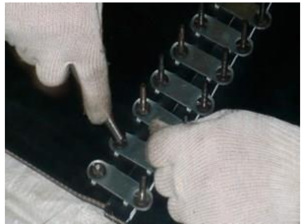
Обламываем или спиливаем излишки болтов
