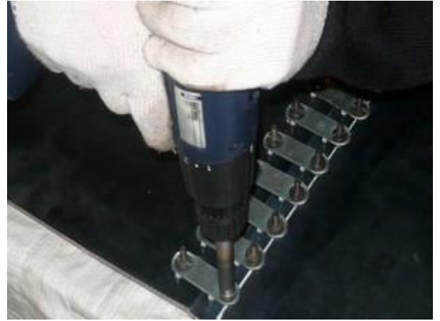
Протягиваем гайки шуруповёртом (а)
